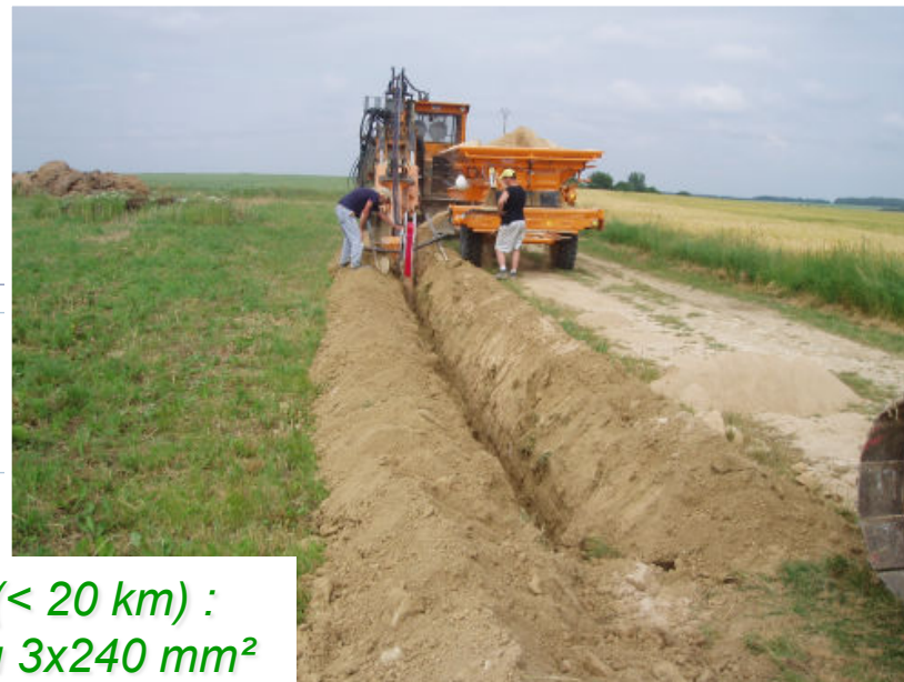
Enfouissement câbles : 0,5 à 1 m de profondeur
