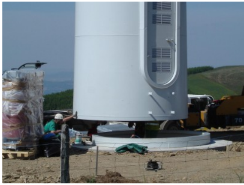
Assemblage des tronçons de mât
