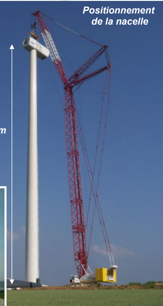
Levage de la nacelle
