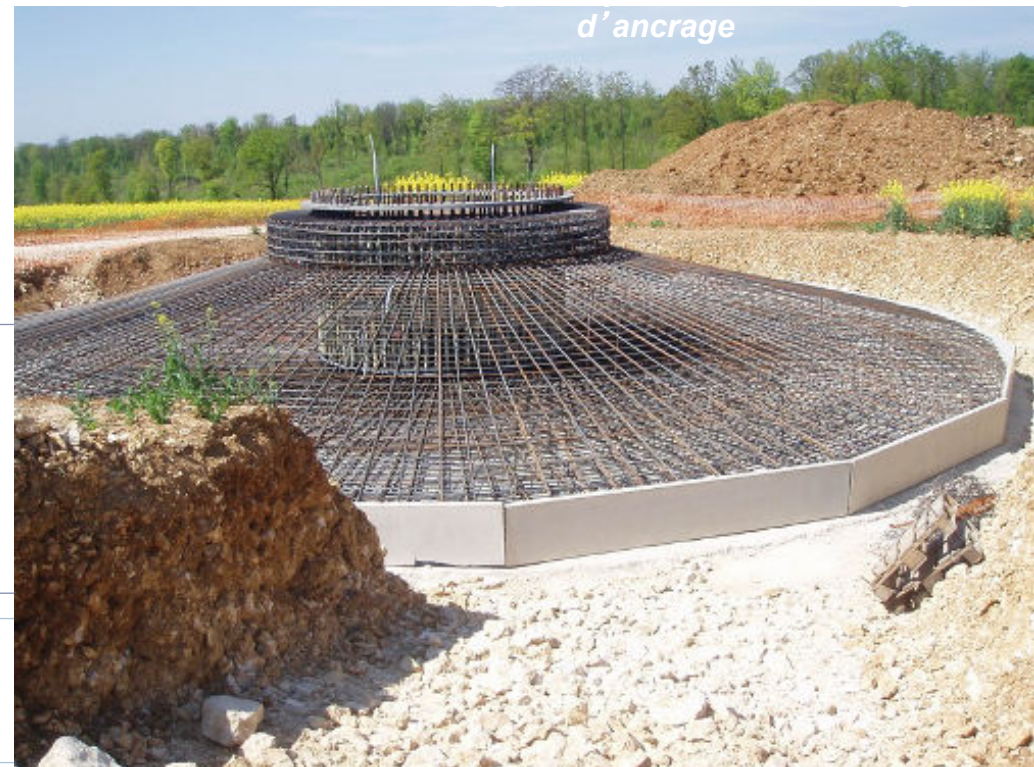
Début du ferrailage autour de la cage d'ancrage
