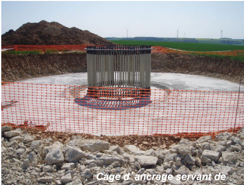
Début du ferrailage autour de la cage d'ancrage
