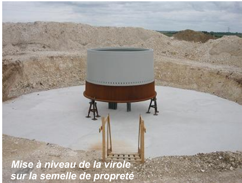
Virole intégrée aux fondations après coulage du béton en une seule fois
