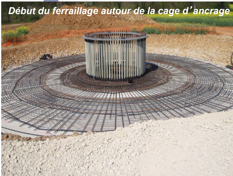
Cage d'ancrage servant de
